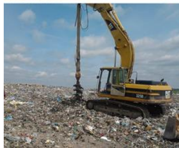
8. ábra: Furatok készítése a depóniában.
